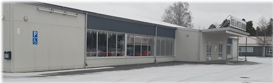
Figur 28. Utanför ishallen finns det en närliggande parkeringsplats för rörelsehindrade. Bildkälla: Sweco.
