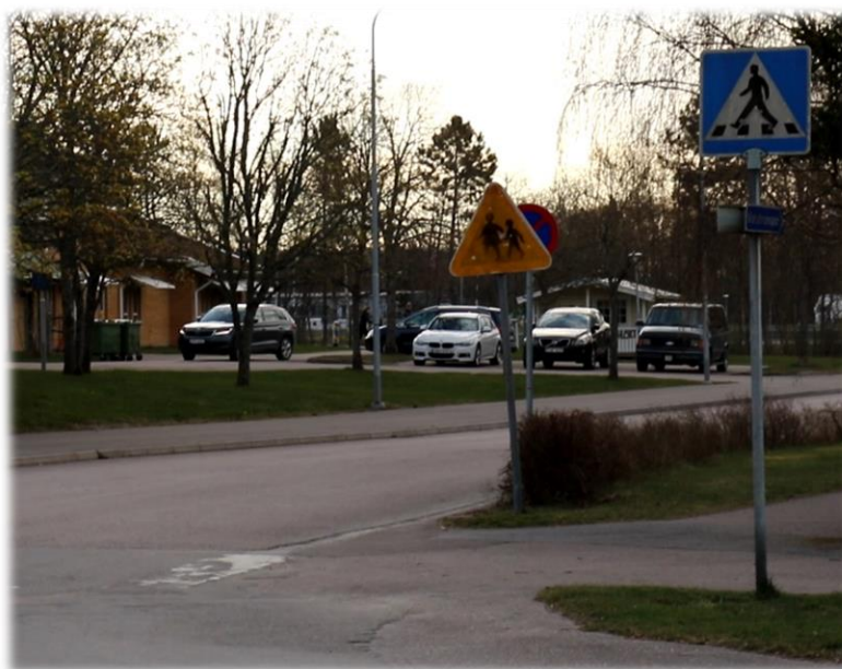
Figur 36. Ingen höjdskillnad eller avgränsning mellan vägbanan och gång- och cykelbanan. Möjliggör att bilar kan gena över en yta som är avsedd för oskyddade trafikanter. Bildkälla: Grästorps kommun.
